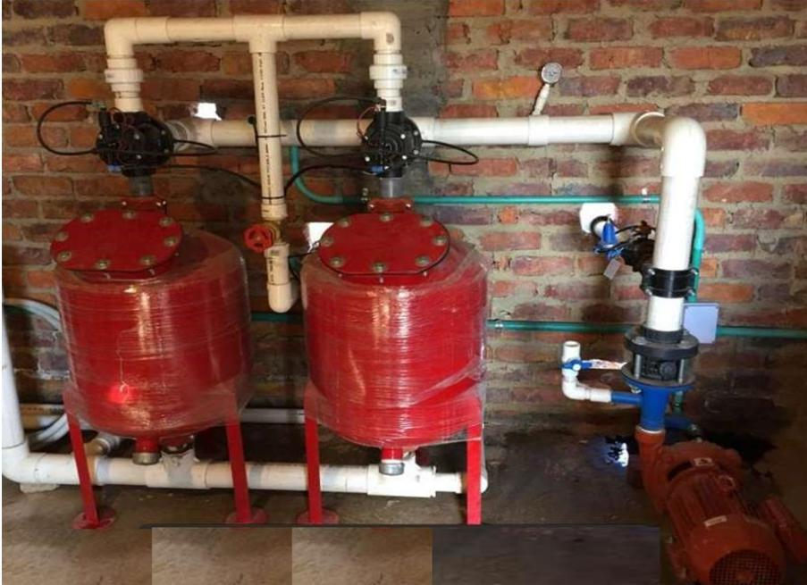
Fig 1. Bomba de 7,5 HP y filtros de arena con válvulas de tres vías.
