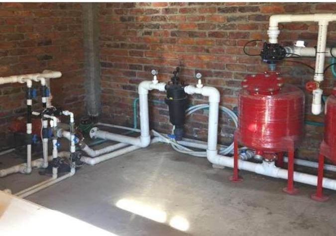
Sistema de inyección proporcional de fertilizantes con dos inyectores Venturi y una motobomba de refuerzo de 2 HP.
