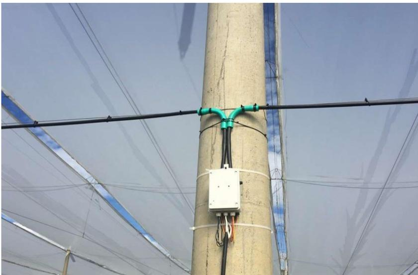
Fig 4. Líneas telefónicas para transmisión de señal y decodificador.
